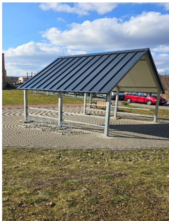
Fotografia 11. Remont wiat rekreacyjnych (PO)
