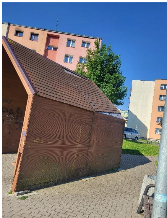
Fotografia 10. Remont wiat rekreacyjnych (PRZED)
