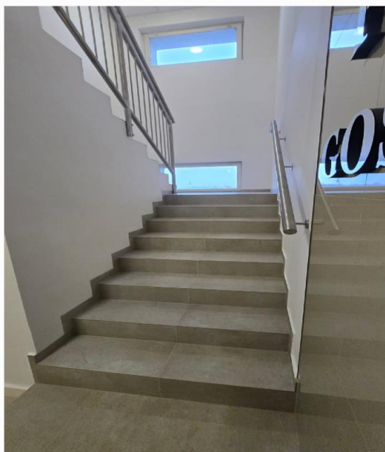
Fotografia 13. Remont schodów wewnętrznych (część hotelowa), ul. Mickiewicza 2a (PO)
