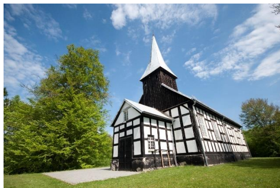
Fotografia 4. Kościół w Wałdowie
