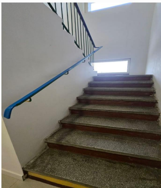
Fotografia 12. Remont schodów wewnętrznych (część hotelowa), ul. Mickiewicza 2a (PRZED)
